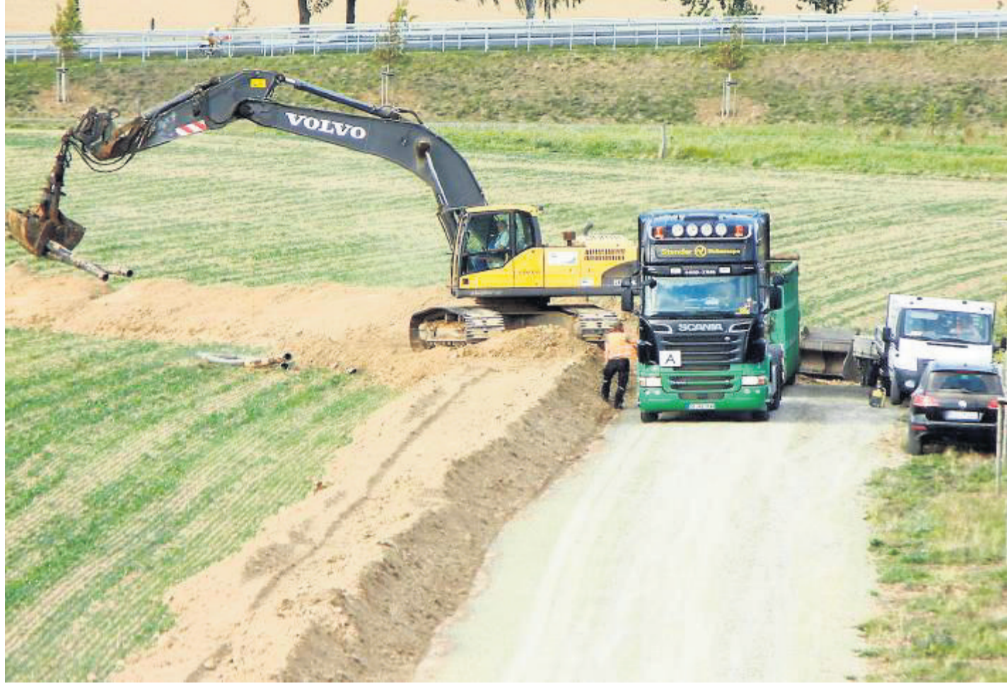
Westfalen Weser Netz lässt im Zuge der Wegebaumaßnahmen eine alte Gashochdruckleitung entfernen.
